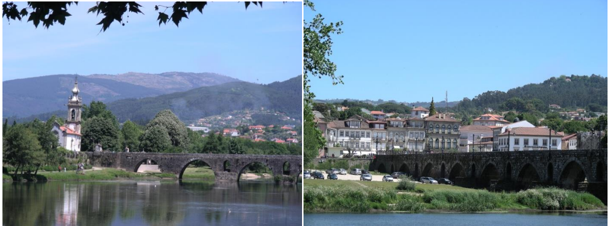
Le vieux pont de Ponte de Lima
